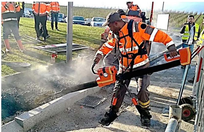
Décembre 2015 : 1 er Test de l'EXO-PUSH sur un chantier Colas à Genève
